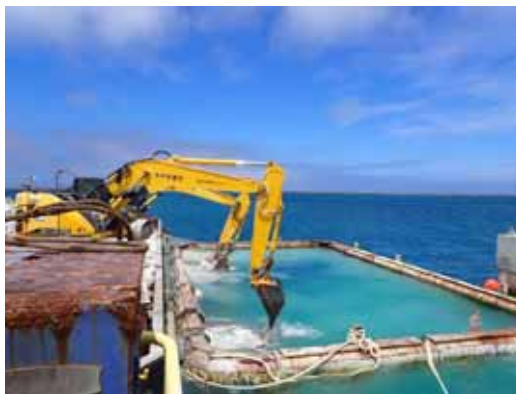
ICT 基礎工 基礎捨石投入
