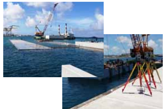
ICT 本体工 ケーソン据付状況
